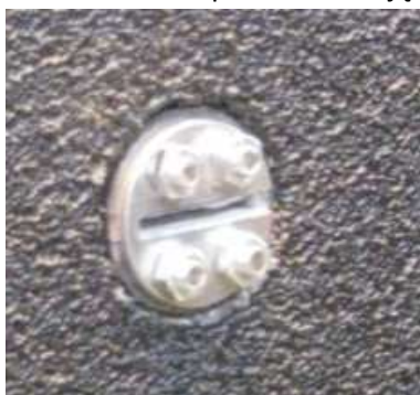
Fot. 3-22 Widok w fundamencie przepust bednarki.
