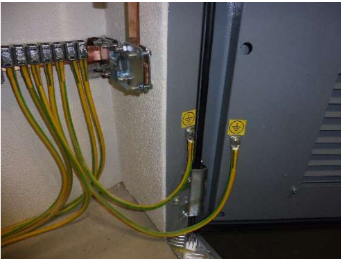
Fot. 3-18 Uziemienie ościeżnicy i drzwi oraz wyprowadzenie uziemienia zewnętrznego.
