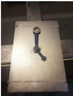
Fot. 3-8 Stopa pod transformator.
