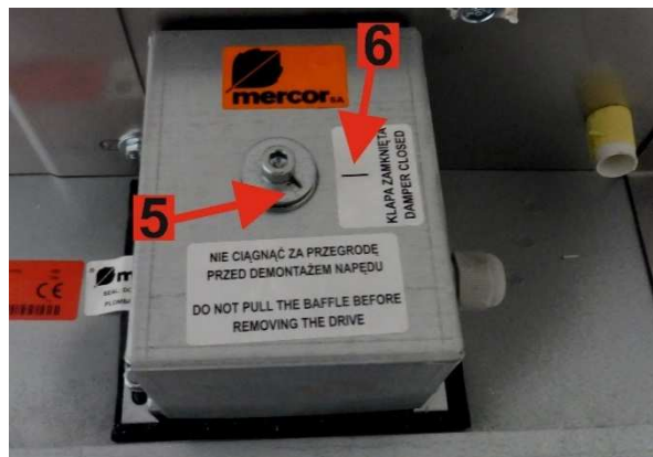
Fot. 3-47 Zewnętrzny mechanizm napędowy
