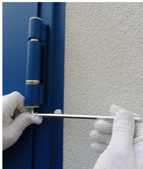
Fot. 11-13 Regulacja drzwi w poziomie
