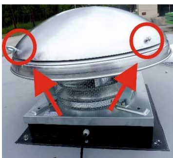
Fot. 4-47 Demontaż pokrywy wentylatora
