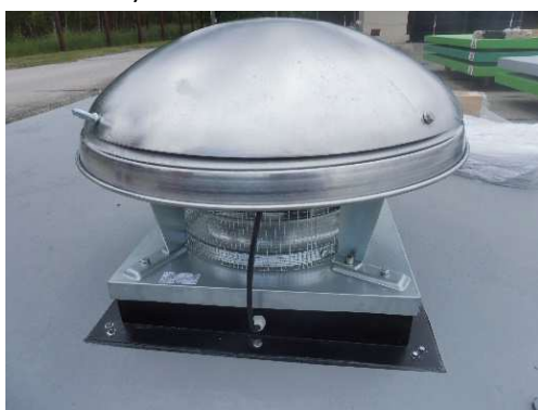
Fot. 4-57 Zamontowany podłączony wentylator dachowy
