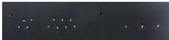
Fot. 6-3 Przepusty kablowe nN i SN.
