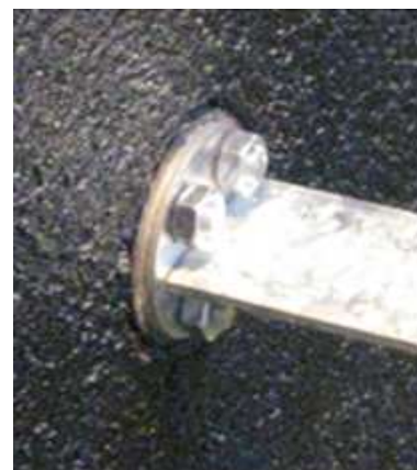
Fot. 3-25 Montaż przepustu bednarki (2).
