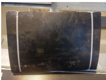
Fot. 3-9 Zamontowana formatka gumowa pod stopą transformatora.
