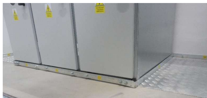
Fot. 3-15 Uziemięcie rozdzielnicy SN
