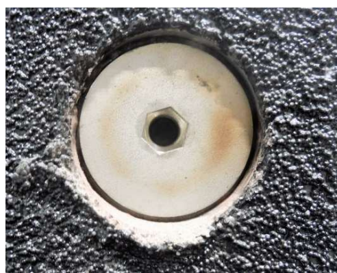
Fot. 3-30 Przepust uziemienia widok w fundamencie, widok z zewnątrz.
