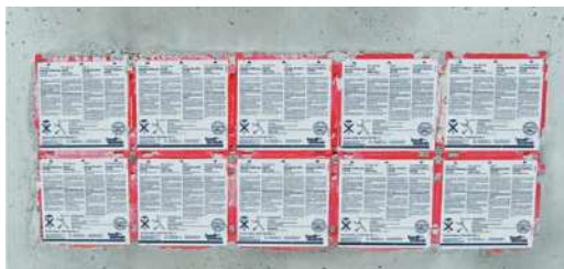
Fot. 6-33. Zamontowane przepusty w fundamencie .
