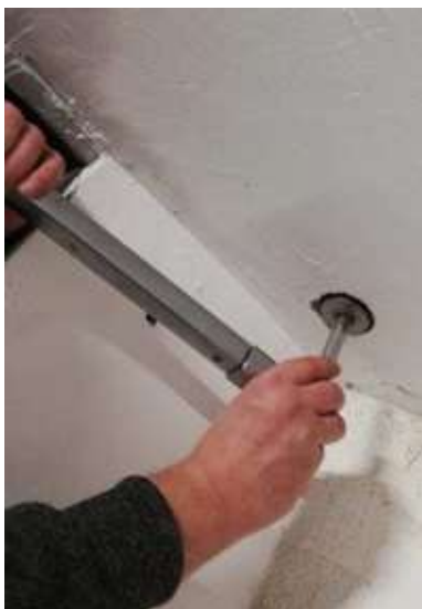
Fot. 3-31 Dokręcanie przepustu uziemienia.
