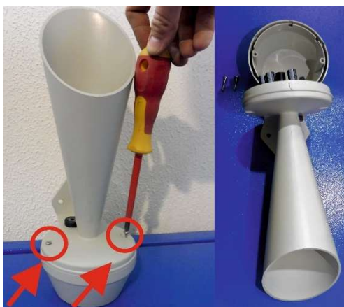
Fot. 4-9. Demontaż buczka.
