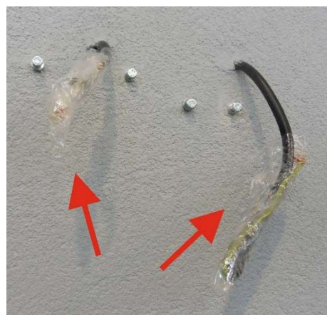
Fot. 4-18. Przewody zabezpieczone na czas transportu.
