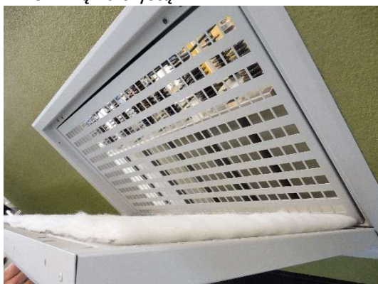
Fot. 11-9 Wymiana włókniny filtracyjnej
