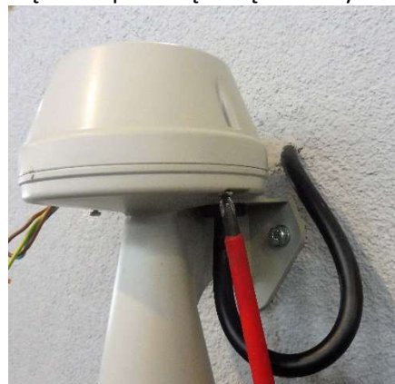
Fot. 4-14. Montaż buczka.
