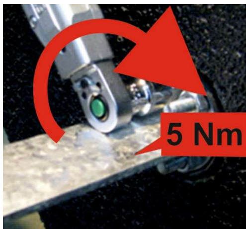
Fot. 3-26 Montaż przepustu bednarki.
