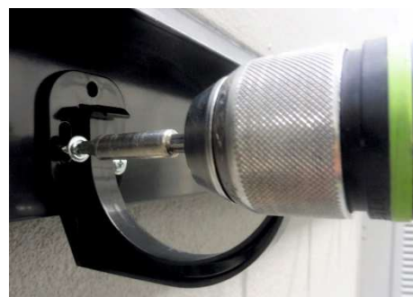
Fot. 4-27. Montaż uchwytych rynnowych.
