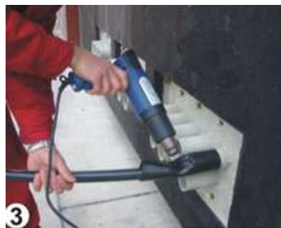
Fot. 6-28. Montaż kabla w przepuście (3).
