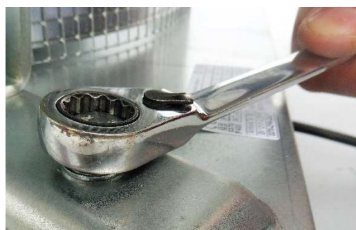
Fot. 4-50 Montaż wentylatora
