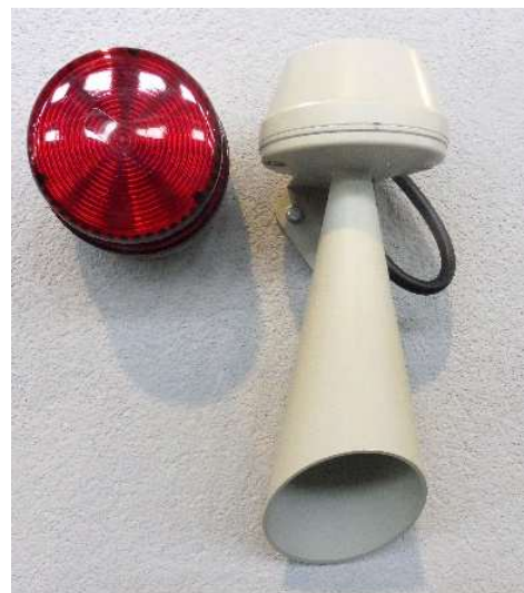
Fot. 4-25. Zamontowana sygnalizacja optyczno-akustyczna.
