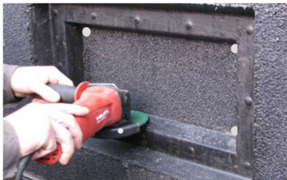
Fot. 6-19. Cięcie betonu szlifierką kątową.
