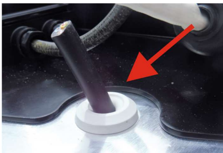
Fot. 4-51 Montaż przewodu
