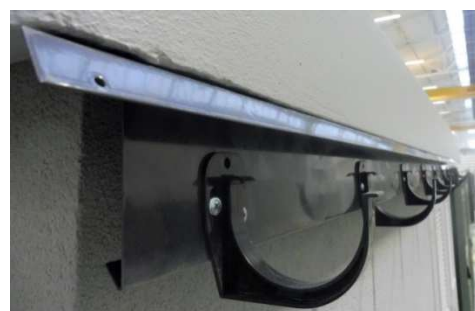
Fot. 4-28. Zamontowane uchwyty rynnowe.
