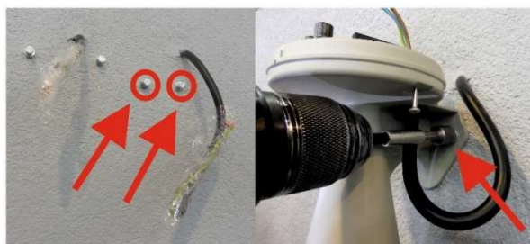
Fot. 4-11. Montaż buczka.
