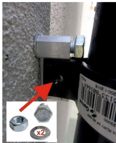
Fot. 4-38. Montaż obejmy rury spustowej.
