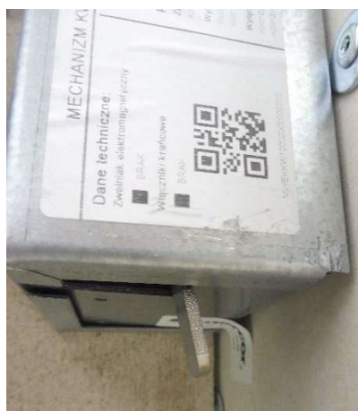
Fot. 3-57 Dźwignia ręcznego zamykania klapy p.poż
