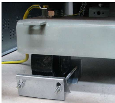
Fot. 3-4. Blokada transformatora zabezpieczająca przed przesuwaniem, producent: ZPUE S.A.
