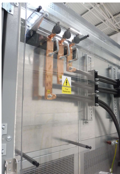
Fot. 5-8 Montaż maskownicy toru szynowego
