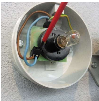
Fot. 4-23 Łączenie przewodów.
