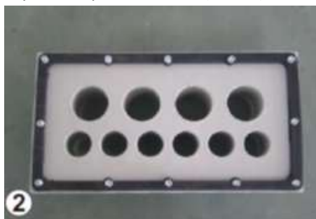
Fot. 6-23. Przepust z gumową uszczelką.
