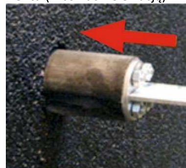
Fot. 3-24 Montaż przepustu bednarki (1).
