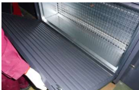
Fot. 11-5 Wymiana filtrów kieszeniowych
