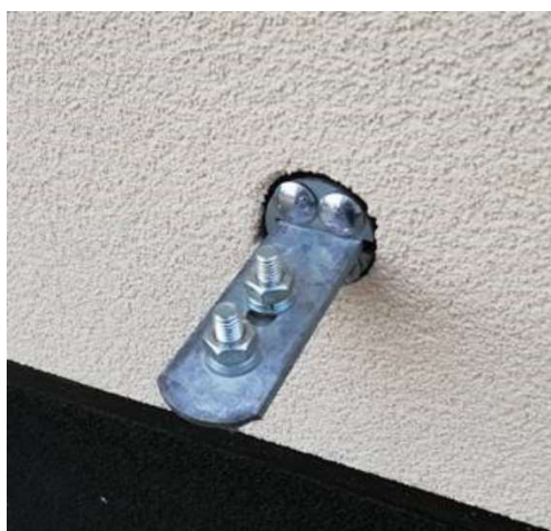
Fot. 3-27 Zamontowany przepust bednarki widok z zewnątrz stacji.
