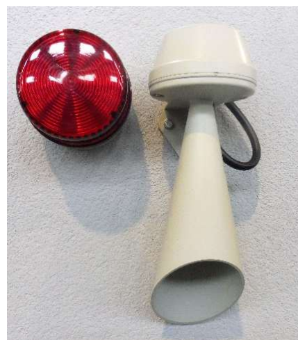
Fot. 4-15. Zamontowana sygnalizacja optyczno-akustyczna.
