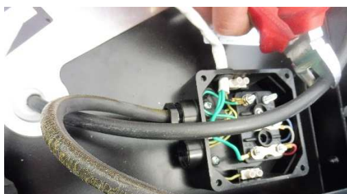
Fot. 4-54 Docinanie przewodu
