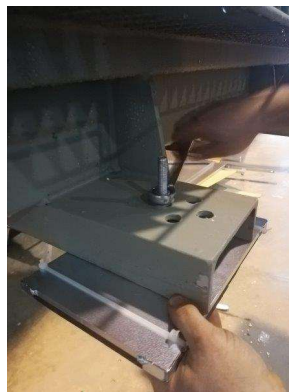
Fot. 3-10 Montaż stopy pod transformator.
