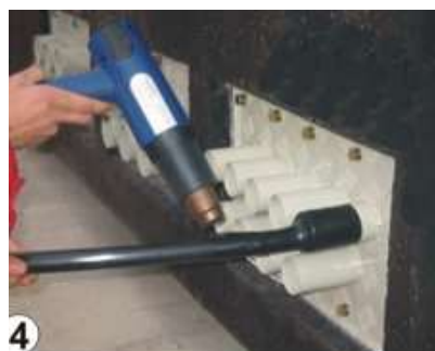
Fot. 6-29. Montaż kabla w przepuście (4).
