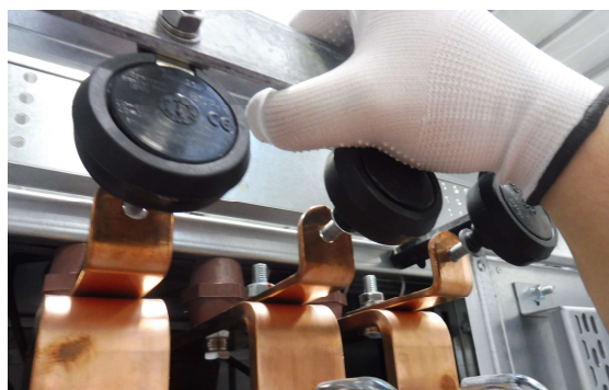
Fot. 5-5 Montaż szyny z ogranicznikami przepięć
