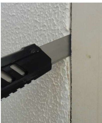
Fot. 3-50 Cięcie obrysu płyty promatect.
