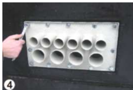
Fot. 6-25. Montaż przepustu kablowego (2).
