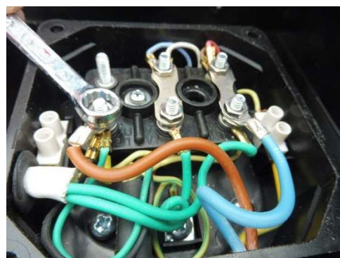
Fot. 4-55 Podłączenie przewodów
