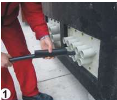
Fot. 6-26. Montaż kabla w przepuście (1).
