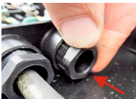
Fot. 4-53 Odkręcanie dławika przy obudowie puszkę zasilającą
