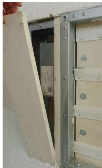
Fot. 3-51 Demontaż płyty promatect
