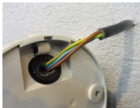
Fot. 4-20. Montaż lampy.
