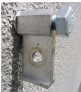
Fot. 4-37. Wspornik obejmy rury spustowej.
