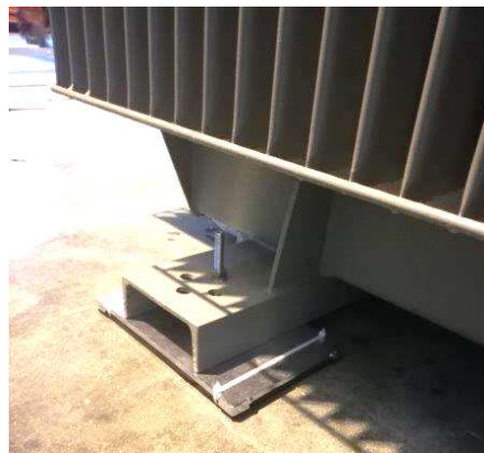
Fot. 3-11 Zamontowana stopa pod transformator.
