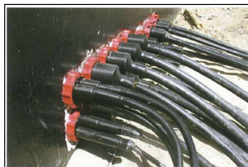
Fot. 6-35. Zamontowane przepusty HSI150/HSI90
