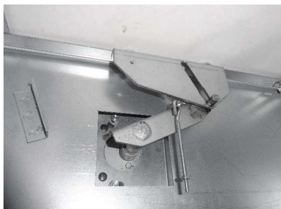
Fot. 3-42 Klapa p.poż. – widok wewnątrz, mechanizm otwierania klapy
