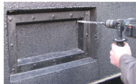
Fot. 6-17. Wiercenie otworów.
