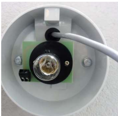
Fot. 4-22. Montaż lampy.
