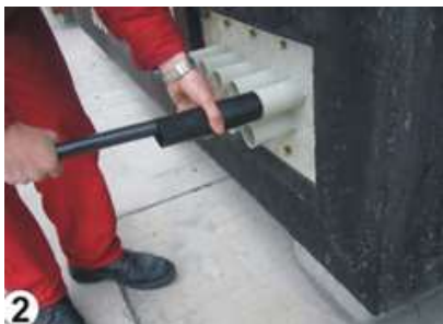
Fot. 6-27. Montaż kabla w przepuście (2).
