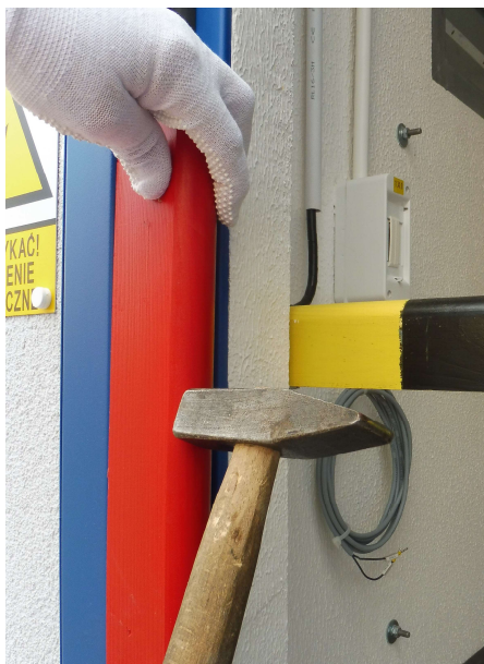
Fot. 11-12 Regulacja drzwi w pionie
