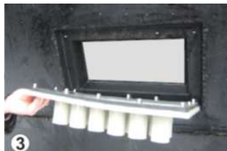
Fot. 6-24. Montaż przepustu kablowego (1).
