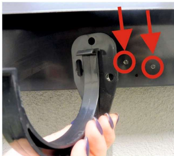
Fot. 4-26. Otwory pod montaż uchwytych rynnowych.
